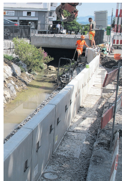
Noch sind die Arbeiten zur Verbreiterung des Uferbereichs im Gange.
