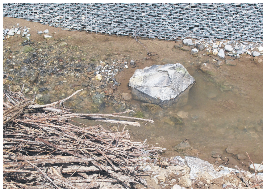
Das revitalisierte Bett des Sarenbachs: Faschinen, Steinkörbe und unter dem Stein bildet sich bereits ein Kolk.
